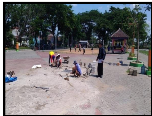
Pembuatan sumur resapan
